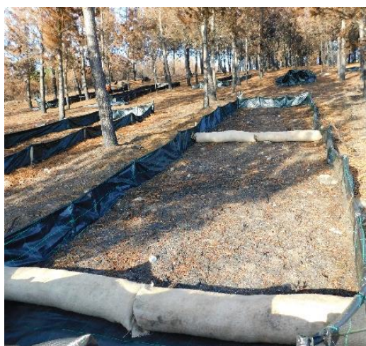
Piloto con geotubos
